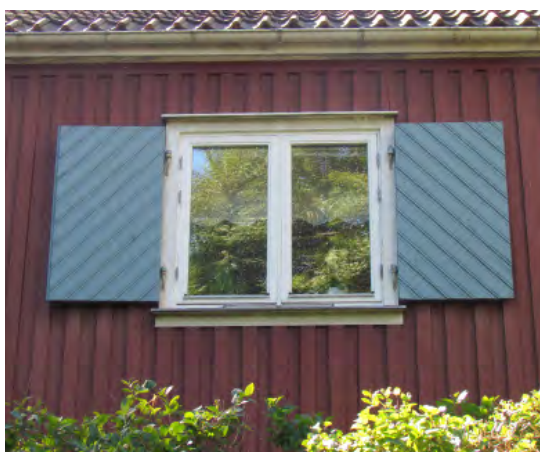
Till vänster en utmejslad detalj i förstukvistens sidor. Nedan ett av fönstren med snedställd panel i luckorna.
