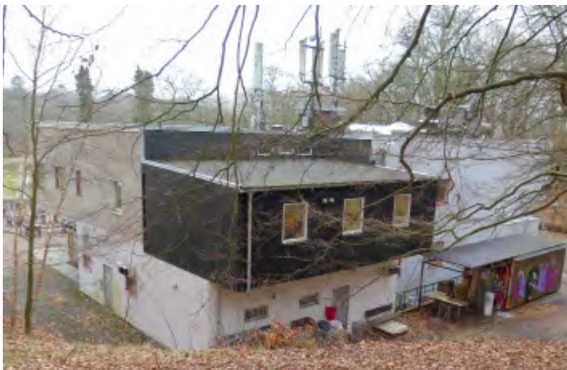
Den norra fasaden. Övre partiet på den äldre byggnadskroppen består helt av vitslammat tegel, här är fönstren röda.
