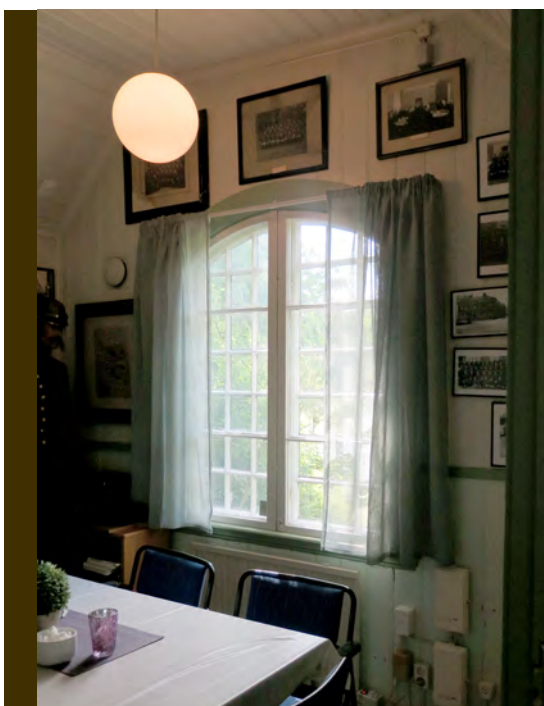
Rum 1, får sitt dagsljus från en fönstergrupp om tre bågar. Ytterbågen är smårutindelad medan innerbågen är delad i två. Se nästa sida
