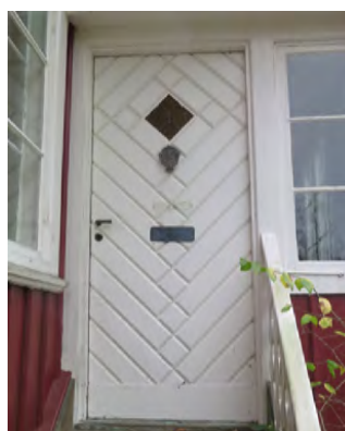
Den befintliga västra dörren kan vara original från 1920-talet.
