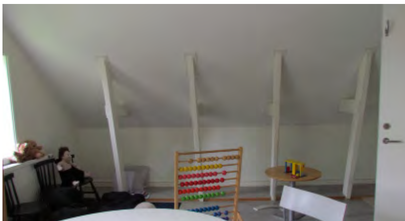
På övervåningen är delar av takstolarna synliga och kattvindarna integrerade i rummet.
