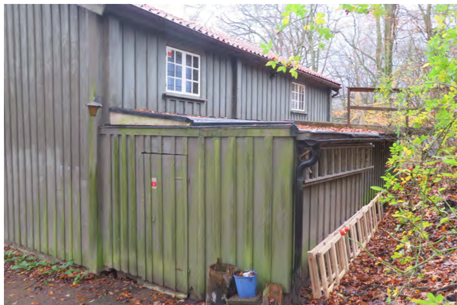
Västra fasaden med tillbyggnaden mot berget. Notera dörren i panelen. Den fungerar som utrymning av bottenvåningen tillsammans med entrédörren.
