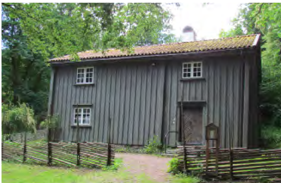
Östra fasaden med entrén. De utstående knutlådorna avslöjar rumsindelningen.
