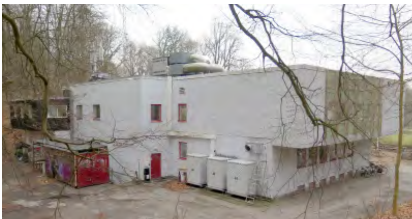
Den södra och den östra fasaden. Här syns den nedre delen med vit spritputsad betong, fönster i rött samt sockel i natursten.
