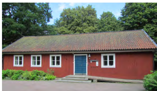
Annexbyggnadens huvudfasad. Notera att fönstren fått samma utformning som på huvudbyggnaden liksom tak-täckningen.
