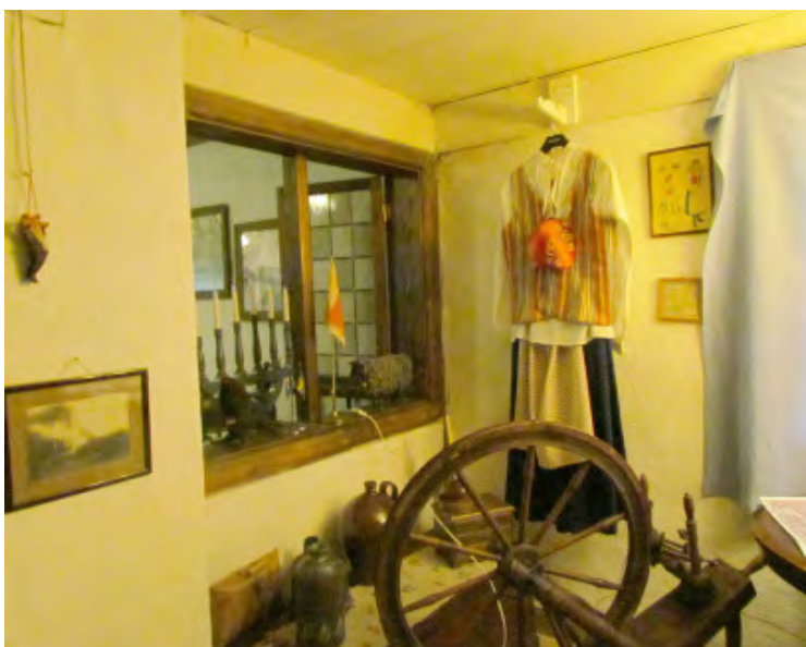
Ett fönster har satts in i väggen mellan nattstugan och kammaren sedan nattstugan började användas för sammankomster.
