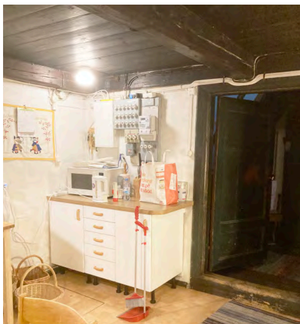
Dörren mot hallen har en ålderdomlig konstruktion med utanpåliggande speglar.
