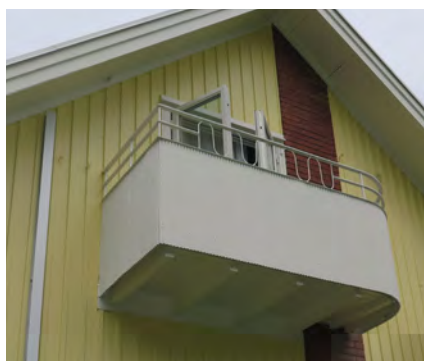
Södra fasaden som är tillbyggd på 1950-talet. Notera balkongens eleganta rundning och den nätta korrugerade plåten. Skorstenen ansluter till värmepannan i källaren.
