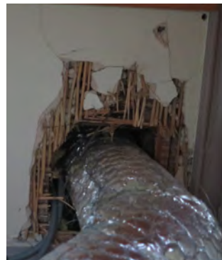
I en garderob på övervåningen syns det putsade taket med sin uppbyggnad av vass. Möjligen ligger ett liknande tak i alla rum över det synliga kassetetaket.
