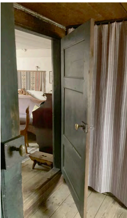
Dörrarna är av ålderdomlig typ med utanpåliggande speglar.
