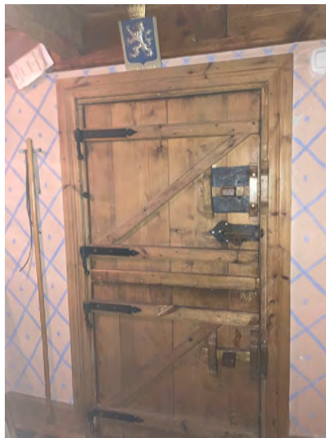
Entrédörrens insida med beslag och äldre lås.
