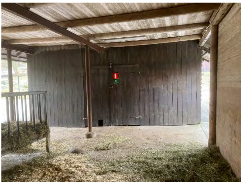
Taket är omålat av bräder som vilar på kraftiga stockar. Bakom panelväggen ryms ett litet snickarrum.
