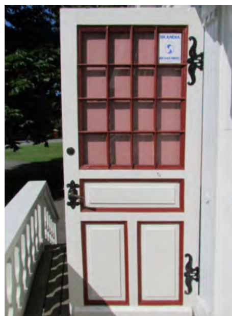
Entrédörren med sin rikt utsmyckade omfattning.. Dörren är en fyllnadsdörr med smårutsindelade fönster i det övre partiet som är igensatt på insidan.
