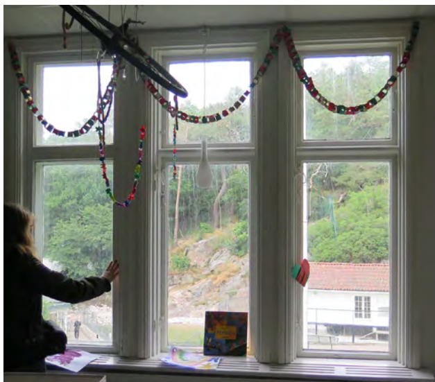
I övervåningens kök som idag är placerat i byggnadens frontespis finns äldre okopplade fönsterbågar. Vid inventeringstillfället hade ett av de tre bågarna insatt innerbåge.
