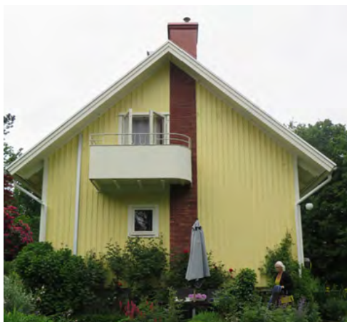
Södra fasaden som är tillbyggd på 1950-talet. Notera balkongens eleganta rundning och den nätta korrugerade plåten. Skorstenen ansluter till värmepannan i källaren.
