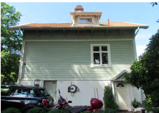
Östra fasaden med husets två ingångar.
