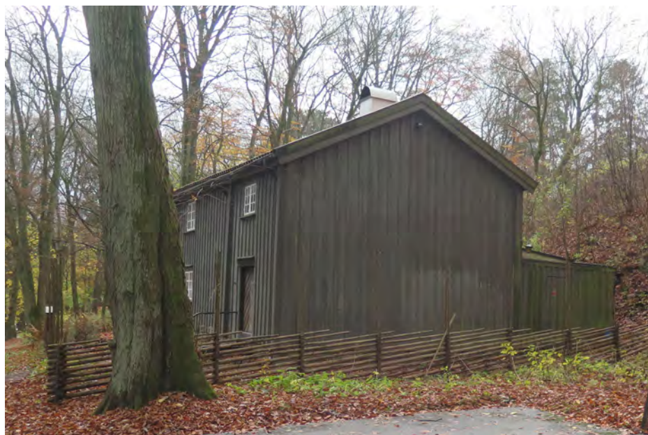
Norra gaveln med tillbyggnaden.
