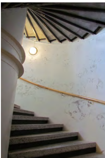
De nedre delarna av trappan har en stålkonstruktion från 1960-talet..
