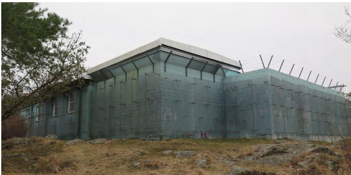
Den sydvästra fasaden.
