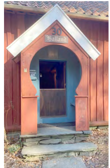
Stentrappen är kallmurad och täcks av en stenhäll som också utgör grund till bislaget.
