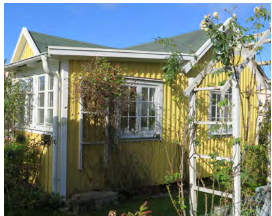
Notera de olika takfallen som vart och ett täcker sin byggnadsdel.
