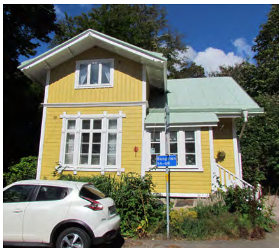
Västfasaden ut mot gatan. Byggnadens takfall är klädda med ett ärggrönt plåttak i bandtäckning.
