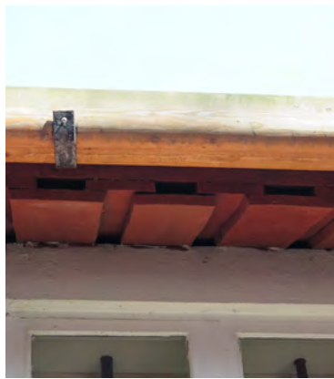
Udertaket är en lockpanel.
