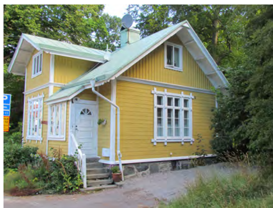
Entréfasaden i söder. Fasadpanelen är liggande i den nedre delen och stående i den övre. En vitmålad gesims delar in fasaden.
