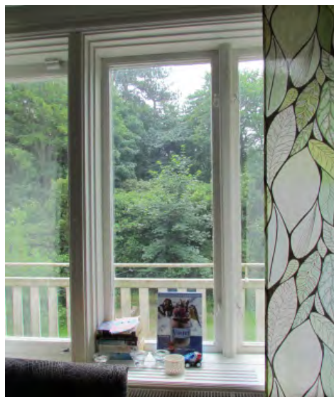
I byggnadens södra frontespis sitter kopplade fönsterbågar.
