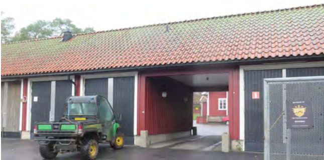
Den södra längan från söder med garageportar och portludret in mot Stallmästaregården.
