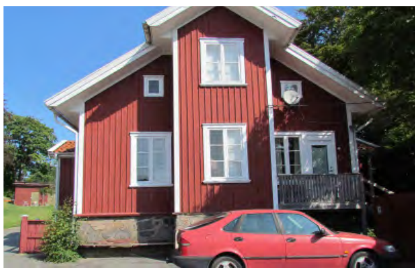
Trapphuset skjuter ut från den södra fasaden och delar på ett originellt sätt tak med övriga huset. De trerutade fönstren är vanligast förekommande och i husets västra del samt i trapphuset är de gamla fönstren bevarade.
