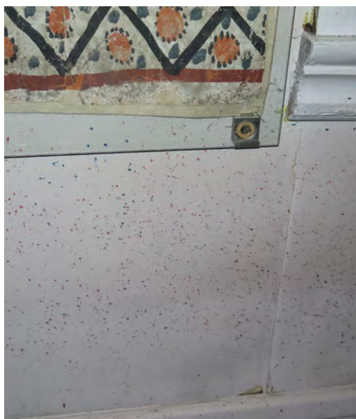
De masoniteklädda väggarna i ororststugan.
