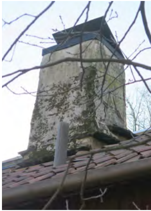
Skorstenen är putsad och har en huv av plåt.
