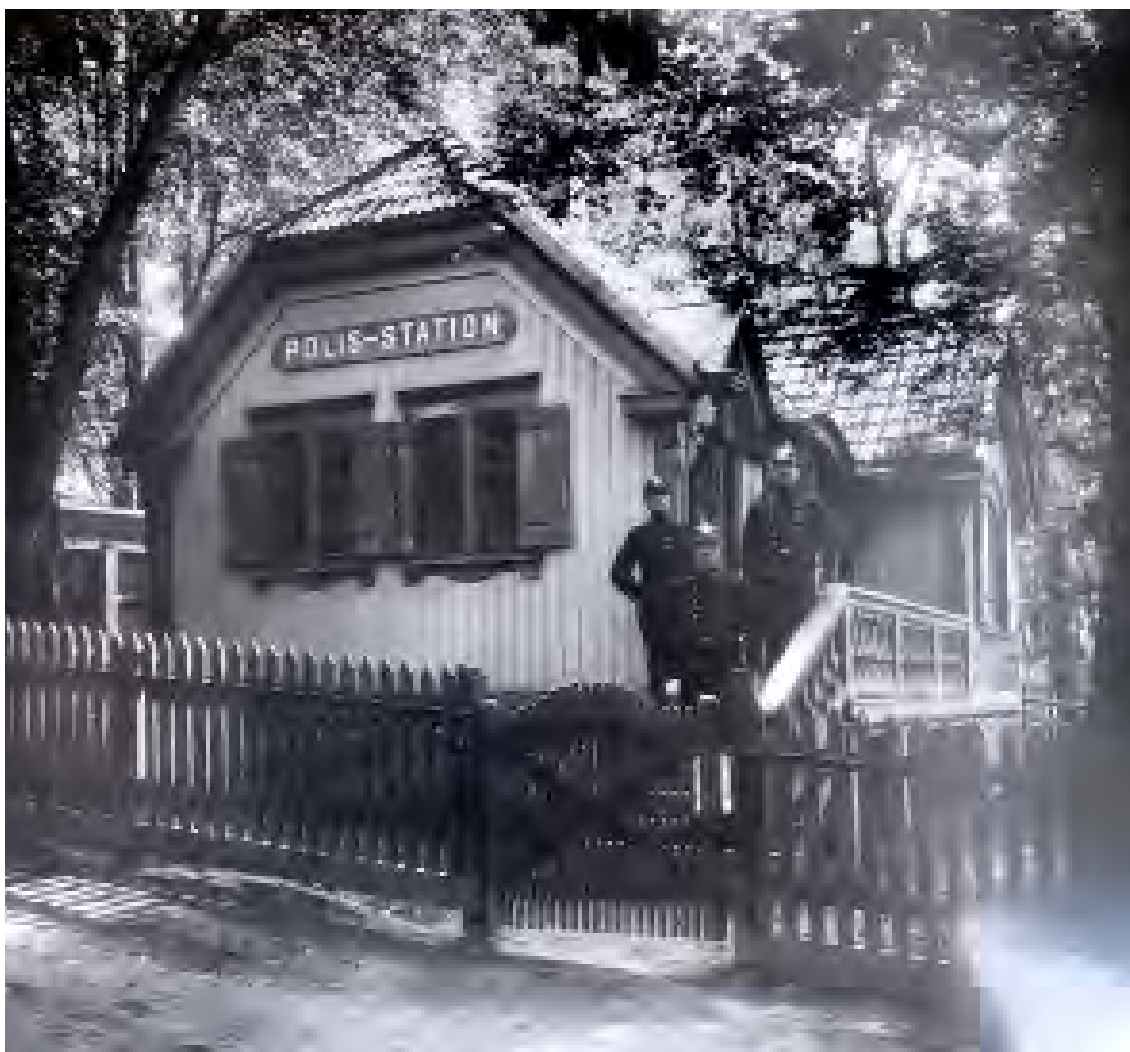
Polisstationen år 1922. Bilden visar ett staket och på baksidan ett plank som tidigare har omslutit byggnaden. Observera kontrasterna hos färgsättningen och de kraftiga fyrkantiga trattarna till stuprören. (Faktarummet, Stadsmuseet)
