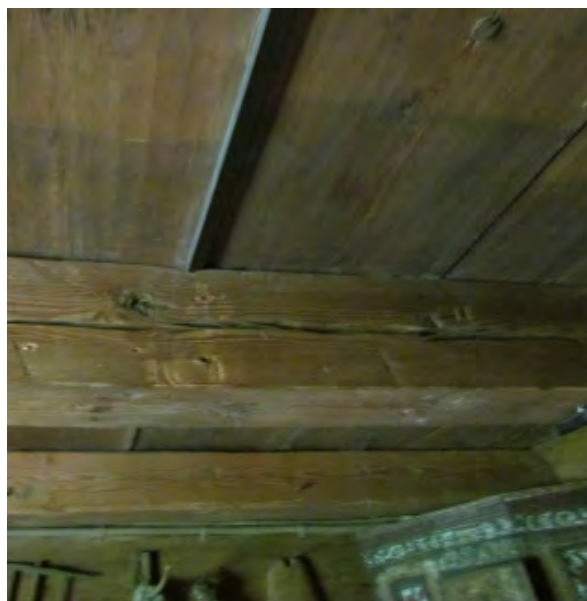
Taket i nattstugan är obehandlat.
