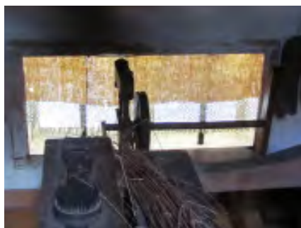
Fönster i ytterväggen på råvinden.
