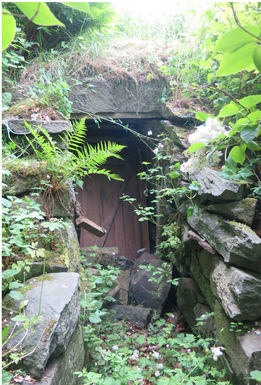
En jordkällare uppförd av granit finns på tomten. Den är gömd i grönska och dörrarna har förfallit. Jordkällare har en tålig och kraftfull konstruktion och går som regel bra att rusta upp.
