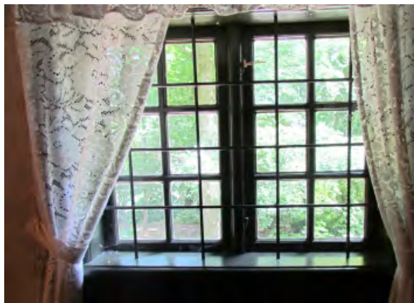
Fönstren är smårutsindelade och har gallerförsatts.
