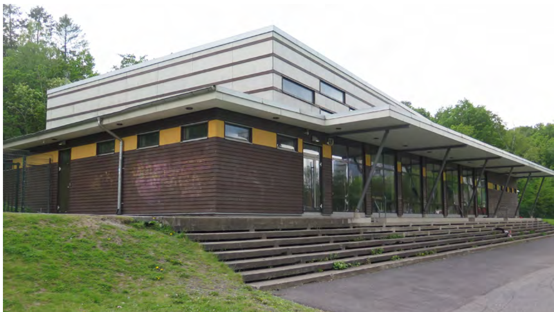
Den lägre byggnadsdelen vetter mott norr och öster. Framför byggnaden åt planerna i norr läktaren med delvis skyddande skärmtak.
