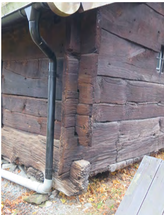
De kraftiga ekplankorna med hörnknutar.
