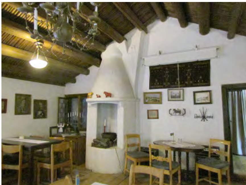
Nattstugans innertak togs bort vid flytten till Göteborg och den öppna spisen fick en ny avslutning uppåt.
