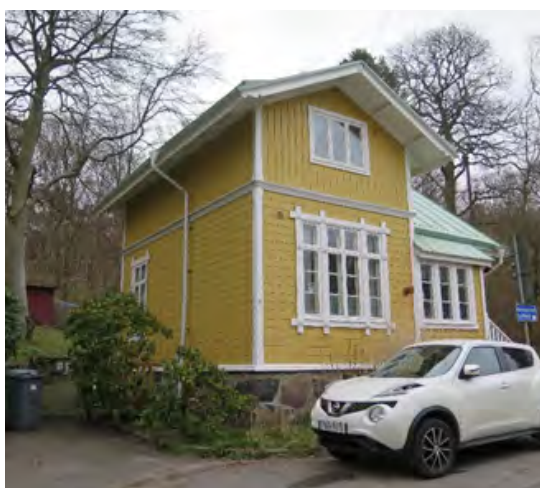
Byggnaden från nordväst.
