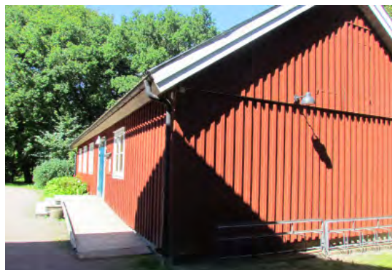
Annexbyggnadens gavel närmast Gräfsnäsgården.
