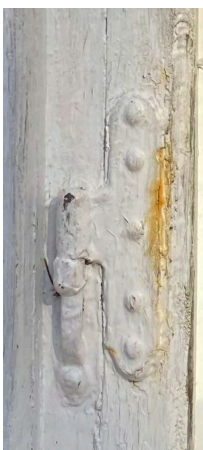
Fönstren är små med spröjs som delar fönstret i fyra rutor. Fönsterbeslagen är enkla och troligen från husets uppförande.
