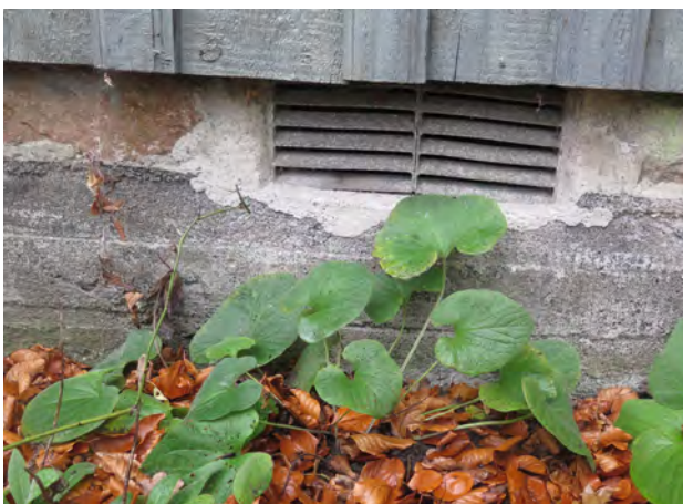
Grunden är gjuten med ett skift natursten närmast syllen.
