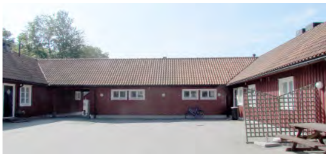
Den södra längan har ett portluder ut mot de kompletterande byggnaderna.
