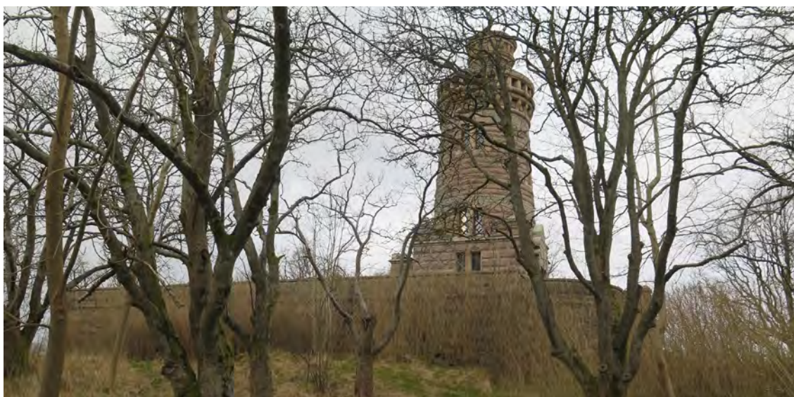
Utsikten från väster, här syns vattenreservoaren som bas för utkikstornet med sin terrass.
