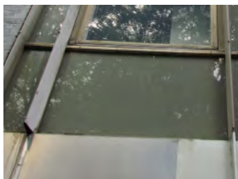
Detalj av den utskjutande delen. Några av de utskjutande guldfärgade vertikala linjerna är trasiga.
