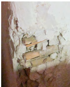
Väggarna är reveterade på vassrör.
