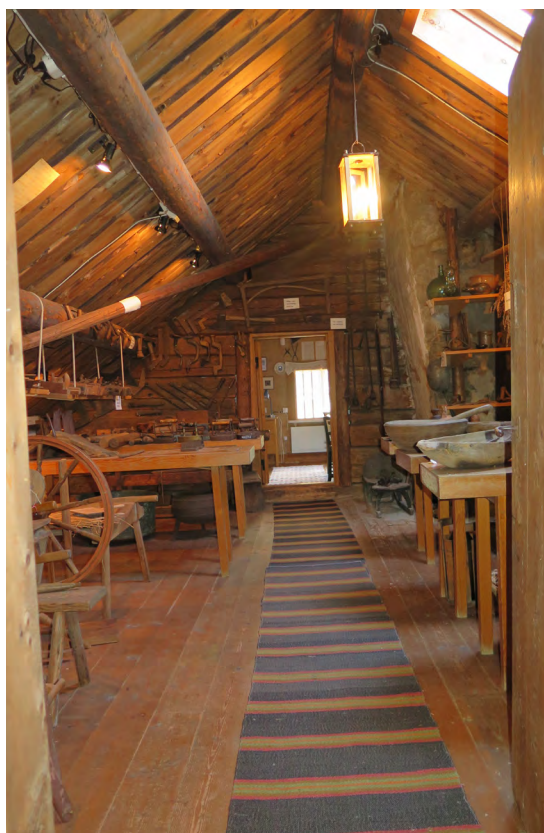
Råvinden över Storstugan används som museirum. Notera takåsarna som håller brädta-ket. Notera också takfönster och längst bort i bilden den kraftiga murstocken.
