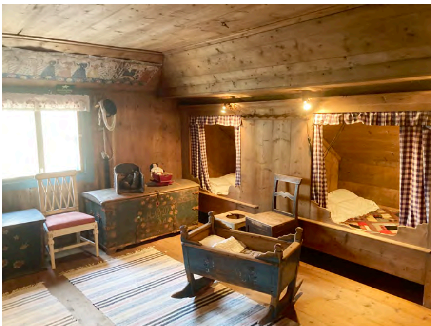
Nattstugan med inbyggda sängar, notera också tredingstaket.
