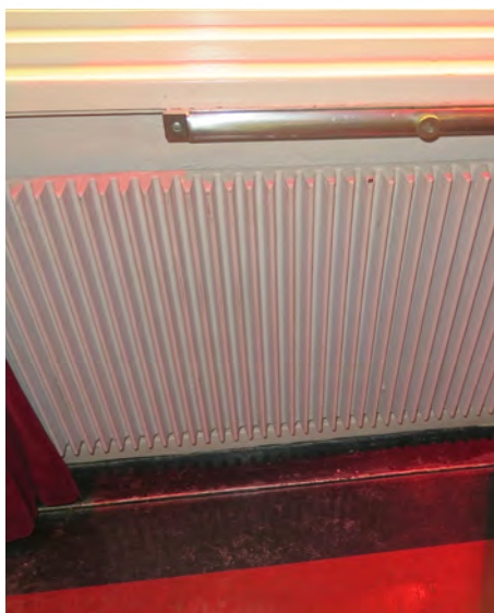
Ovan syns detaljer från bevarad radiator och fönster. Flertalet större fönster är av pivothängd modell med vred. Några fönster är fasta. Radiatorerna är smäckra och tillverkade i gjutjärn.
