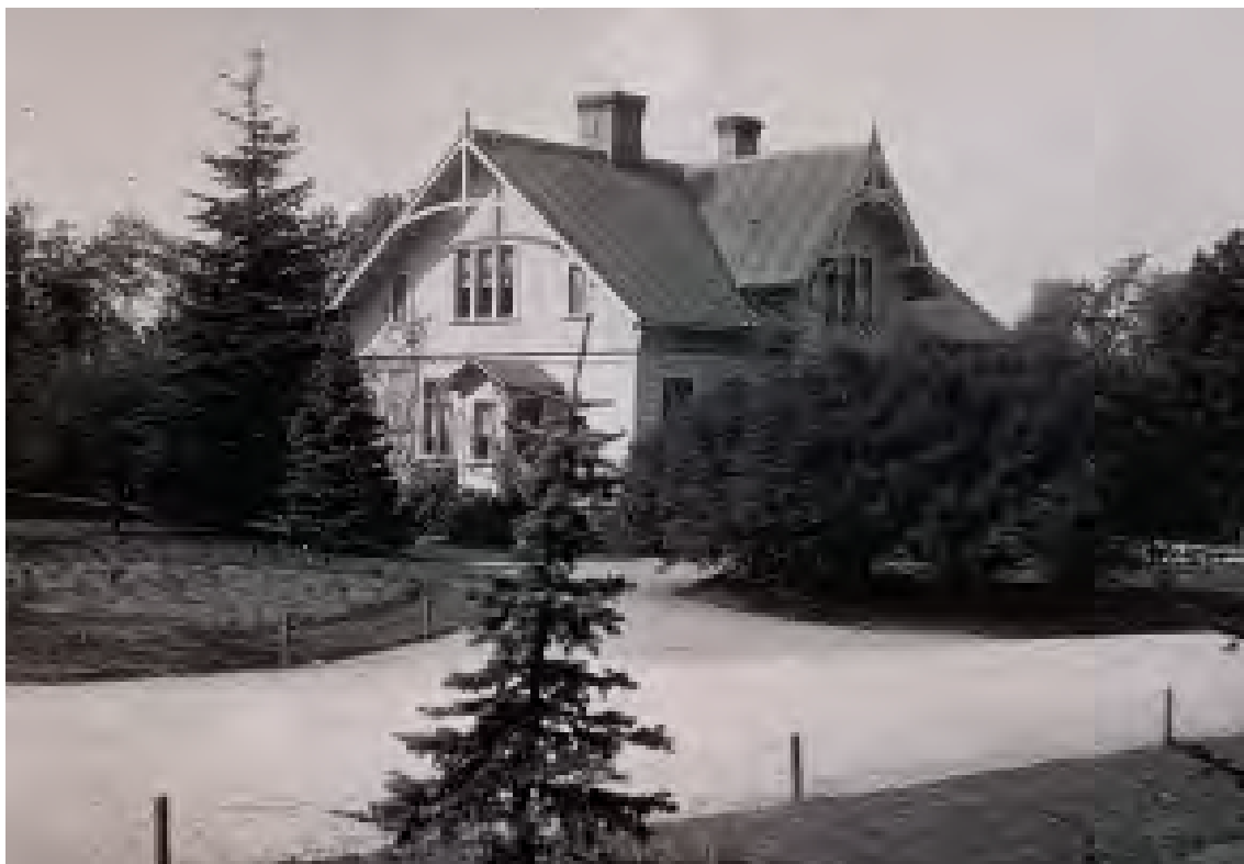
Trädgårdsmästarebostaden från 1895. (Stadsmuseet). Notera trädgårdens planteringar och takets plåt-täckning.
