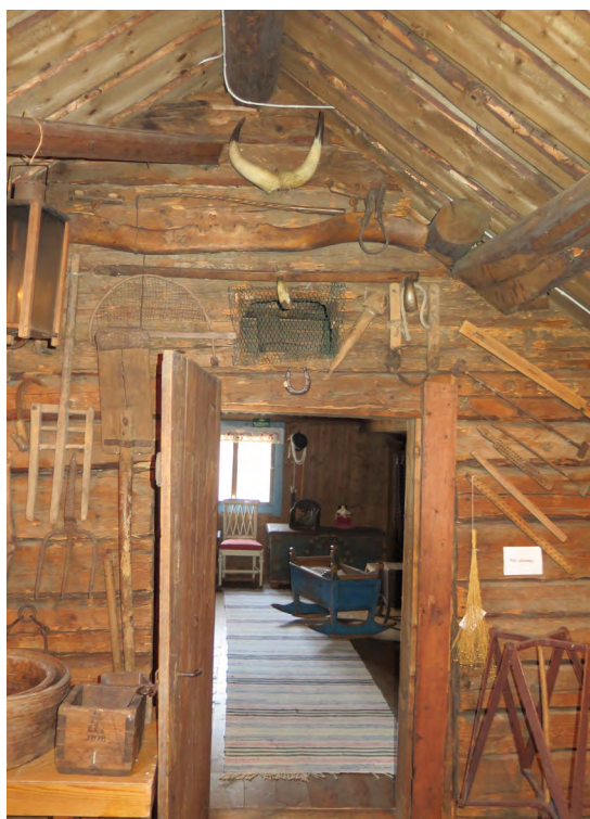
Råvindens gavlar är timrade tillnock. Notera den enkla bräddörren in till det inredda kontoret.
