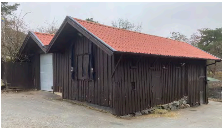
Byggnaden står delvis på en naturstensgrund. Den borte delen av byggnaden är troligen tillbyggd senare.
