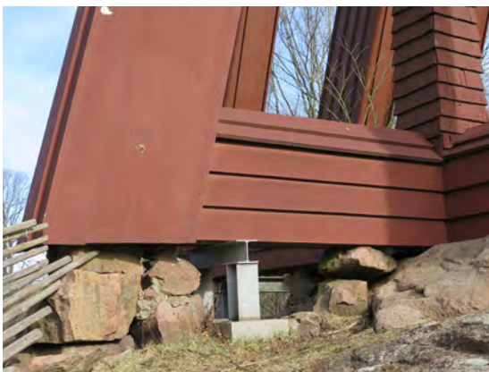
Klockstapeln är förankrad med stål balkar.
