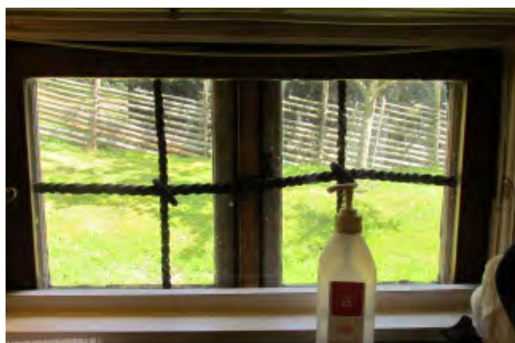
I mjölkkammaren, som har inretts till ett modernt kök, finns de äldre fönsterbågarna kvar.
