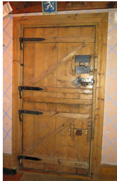
Entrédörrens insida med äldre lås och vackra beslag.
