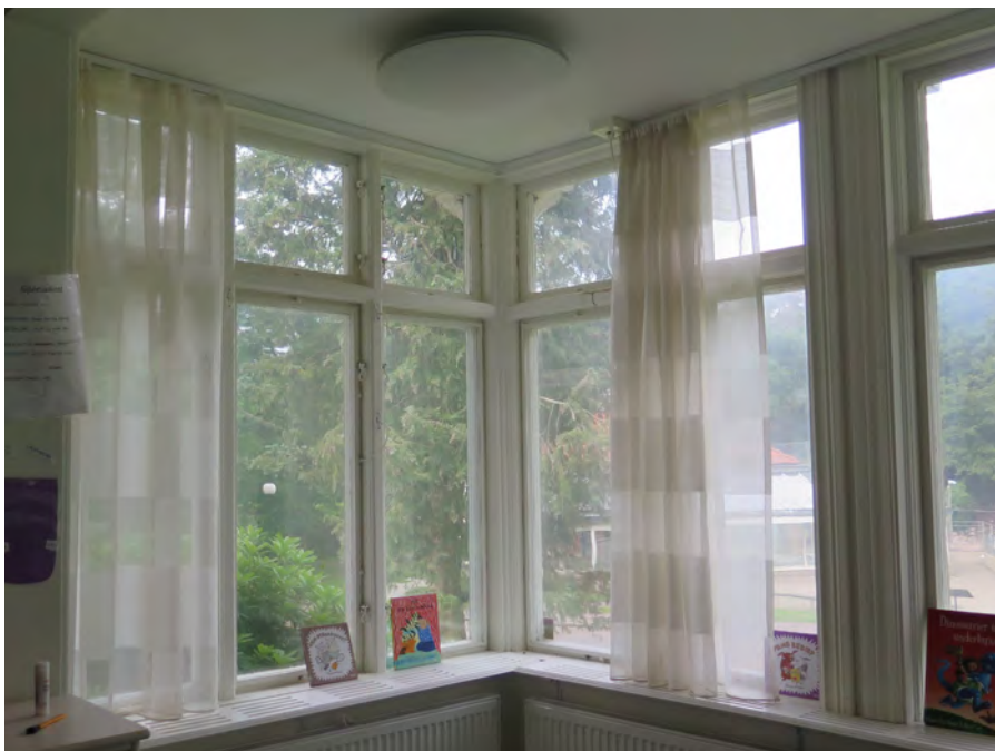
Verandan som från början var en öppen bygnadsdel utanför huskroppen har genom flera ombyggnader integrerats i den stora trapphallen.
