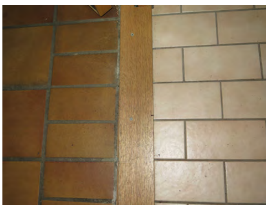
Entréhallen med utställning om rymden. Väggarna består av vitmålad betongsten. På golvet ligger rödgul klinker.
