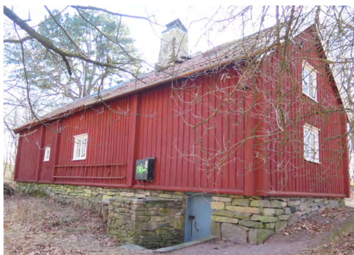
Östra fasaden. Här syns de brädslogna knutarna tydligt och man kan lätt avläsa rumsindelningen.
