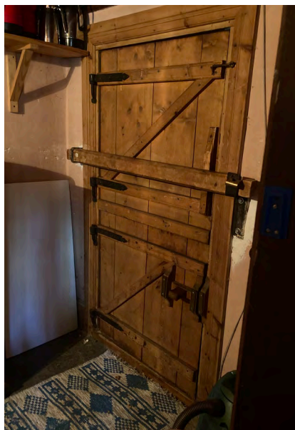
Entrédörren i form av halv-dörrar.
