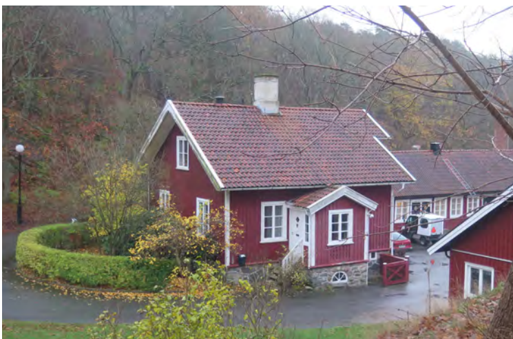
Trapphuset skjuter ut från den södra fasaden och delar på ett originellt sätt tak med övriga huset. De trerutade fönstren är vanligast förekommande och i husets västra del samt i trapphuset är de gamla fönstren bevarade.
