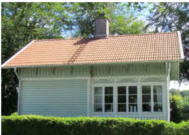
Västra fasaden. Fönsterpartiet markerar den tidigare verandans placering. Notera de omsorgs- fullt utformade taktassarna.
