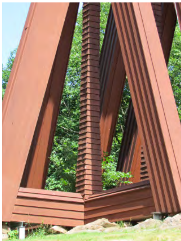
Innerstolparna är beklädda med fiskfjällspanel.
