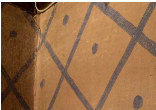
Hallens väggar är reveterade och målade i ett rombiskt mönster.
