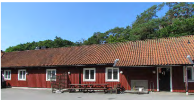
De uppbyggda längorna från 1990 har inga spröjs i fönstren men följer i övrigt samma uttryck som den äldre längan. Här den västra längan.
