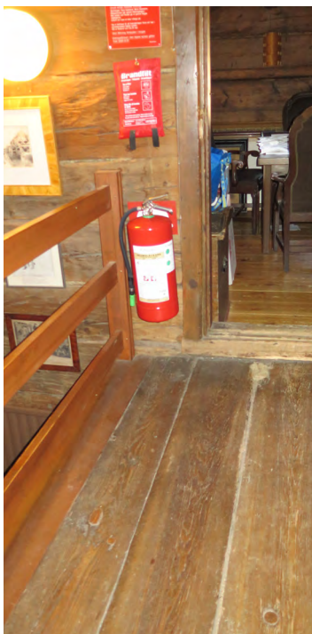
Uppe på loftet ligger ett modernare brädgolv..
