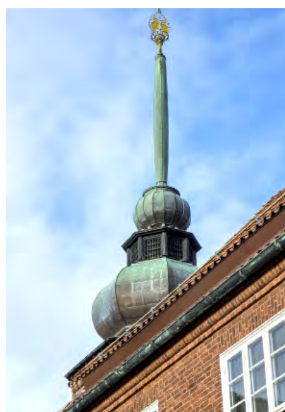
Till vänster ett litet burspråk på fasad. Till höger koppar-kupol med spira. (Higab).
