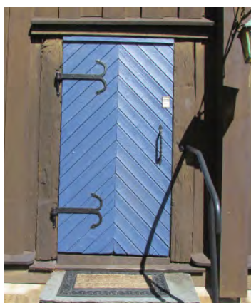
Huvudentrén är traditionseentligt inåtgående, en pardörr med snedställd fiskbenspanel.
