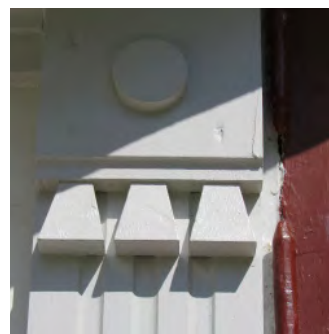
Detalj av fönsteromfattning på den västra fasaden.
