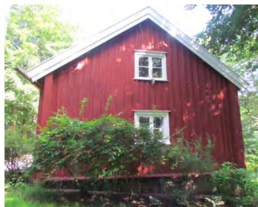
Södra fasaden. Notera att grunden tar upp markens ojämnhet.
