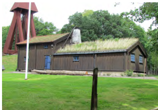
Smålandsstugan idag. Mindre förändringar har skett, bland annat har grunden förstärkts och fasaden fått en mörkbrun kulör. Den röda klockstapeln syns i bakgrunden.
