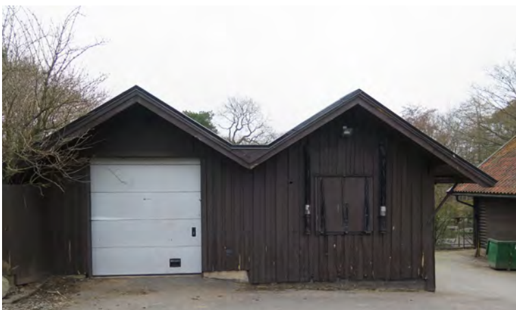
De två byggnaderna är sammanbyggda.
