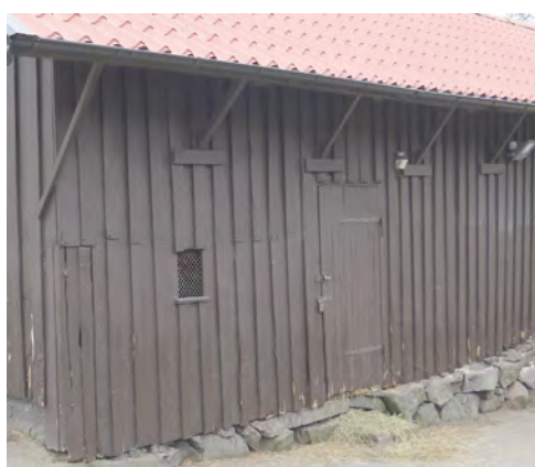
Delar av takstolen är synlig i exteriören.
