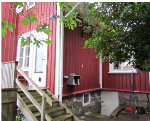
Terrassutbyggnaden vid den östra lägenheten.
