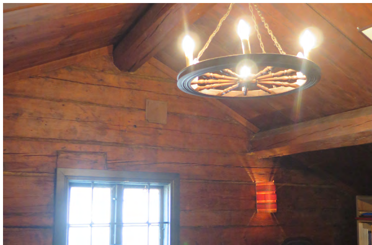
Loftet har synliga timmerväggar och åstak.
