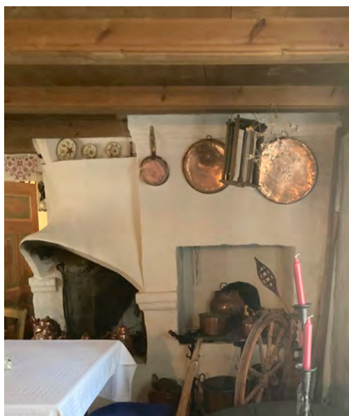
Bredvid den öppna spisen finns en separat bakugn.
