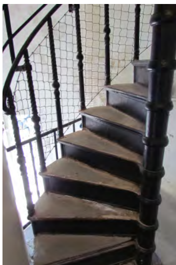
Den sista trappan högst upp i tornet är av gjutjärn och kan vara original sedan byggnadstiden.
