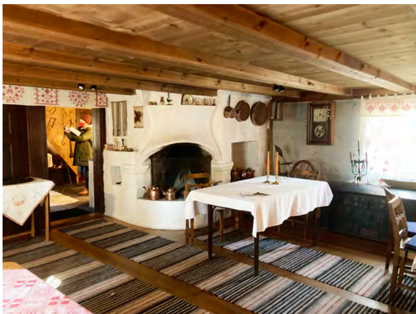
Stugan med sitt imponerande spiskomplex. Notera också taket som vilar på panelinklädda bjälkar.
