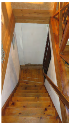
Trappan upp till vinden från köket är modern.
