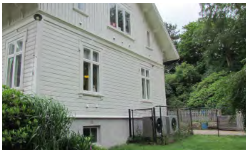
Staketet har tillkommit i samband med förskoleverksamheten. Kraftiga ventilationsagregat är placerade invid den östra fasaden
