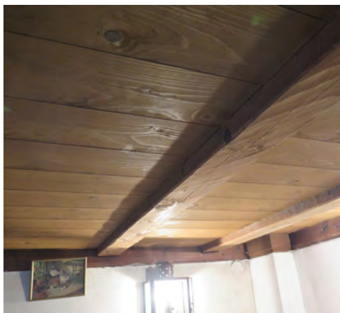
Taket i köket och i flera av rummen är isolerat nedåt så att takbjälkarna bara sticker ner några centimeter
