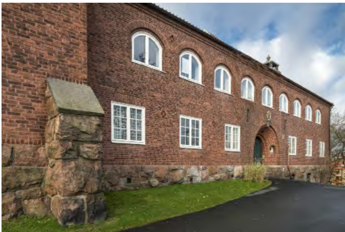
Östra fasaden på den gamla delen. (Higab).
