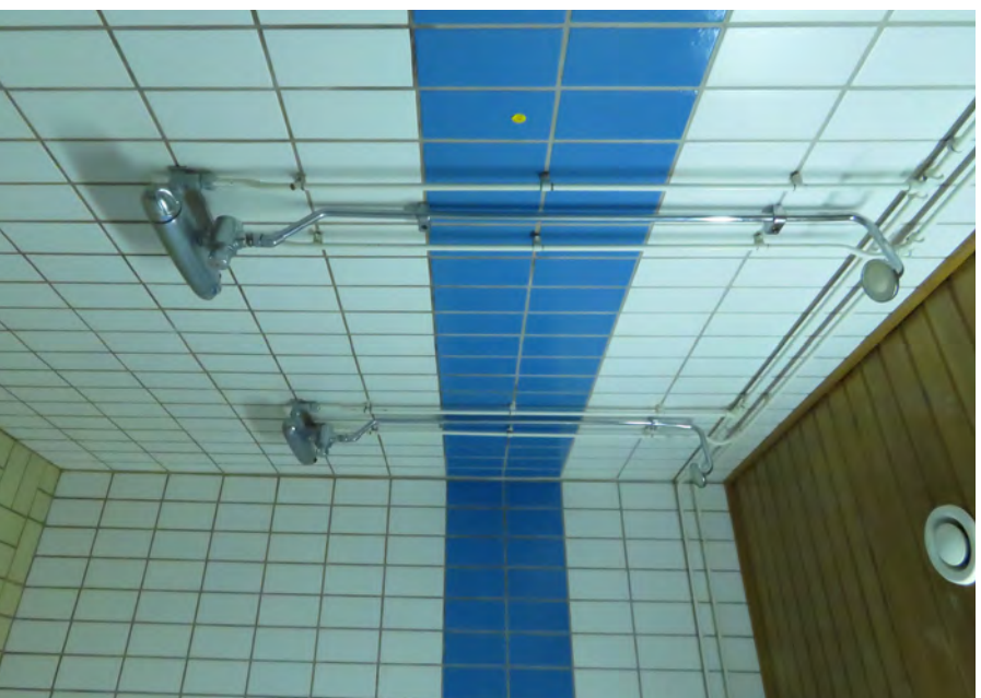
Duschrum i omklädningsrummen.
