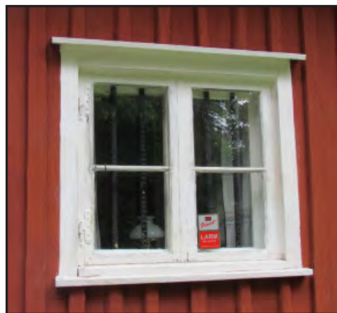
Fönstren är små med spröjs som delar fönstret i fyra rutor. Fönsterbeslagen är enkla och troligen från husets uppförande.
