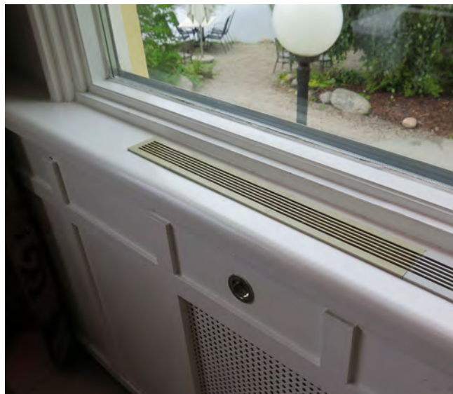
Ovan syns detaljer från bevarad radiator och fönster. Flertalet större fönster är av pivothängd modell med vred. Några fönster är fasta. Radiatorerna är smäckra och tillverkade i gjutjärn.
