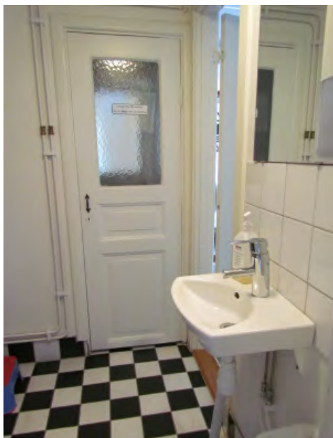
I våtutrymmet på övervåningen finns en äldre dörr som troligen kom till vid 1930-talets ombyggnad.
