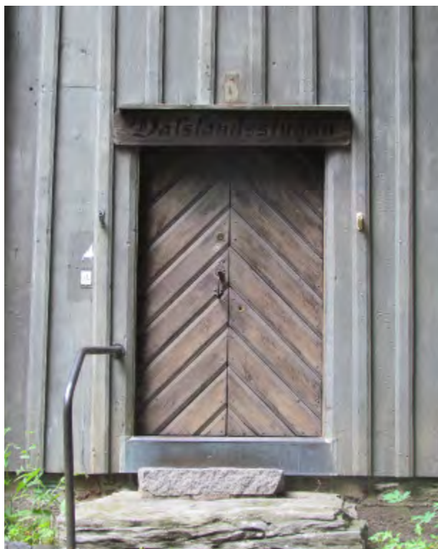
Entrédörren är traditionenligt inåtgående. En pardörr med snedställd panel.
