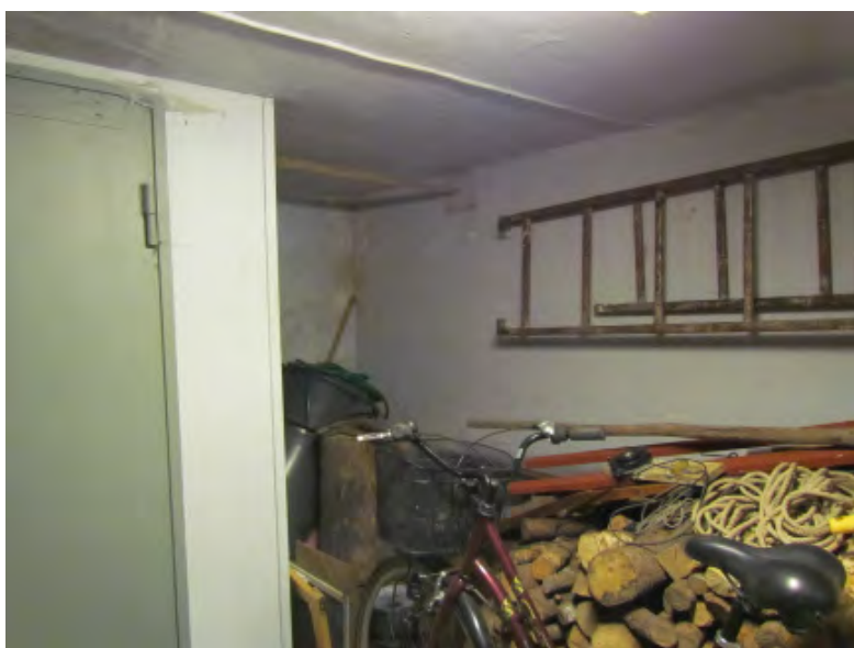
Källaren har putsade tak och väggar
