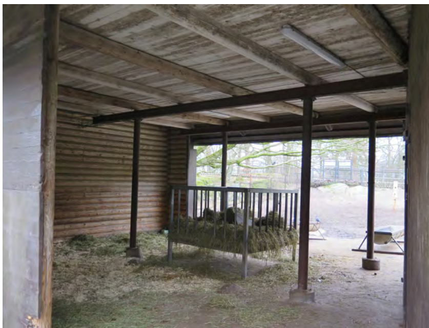
Ligghallen har genomgående öppningar på långsidorna. På ena kortsidan syns liggtimret.
