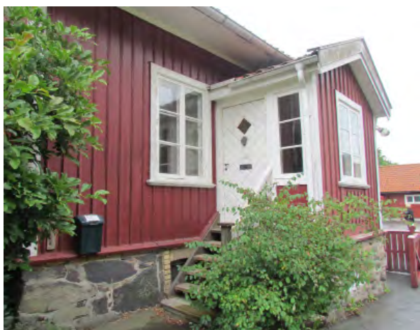
Den västra fasaden med den lite mindre farstuutbyggnaden. Notera att taket skjuter över rejält och har skyddats med en slät hyvlad vit panel. Husets släthuggna granitfot.
