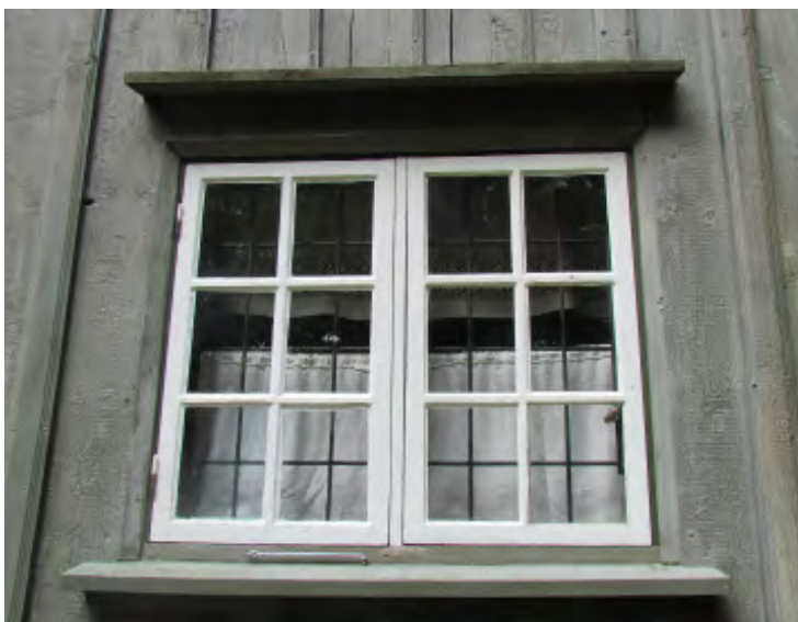
Fönsterna är sexdelade med mittpost. De är tidstypiska och värdebärande.
