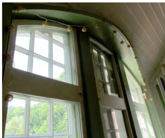
Rum 1, får sitt dagsljus från en fönstergrupp om tre bågar. Ytterbågen är smårutindelad medan innerbågen är delad i två. Se nästa sida
