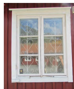
Den östra längans fasad mot vägen. Notera skillnaderna i grundens gjutning. Fönstren är spröjsade.
