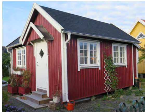
Notera krypgrunden, de smårutsindelade fönstren och den stående locklistpanelen.
