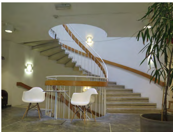
I det omsorgsfullt utformade centrala trapphuset möter naturstensgolvet trappans terrazzosteg.
