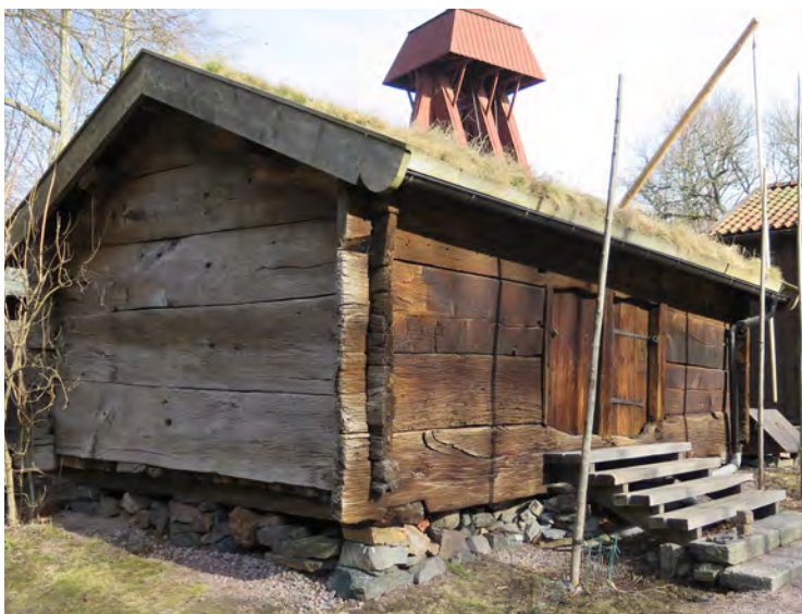
Visthusboden från gårdssidan med trappa och låga dörrar.
