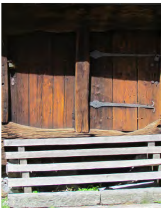
De äldre dörrarna på visthusboden.
