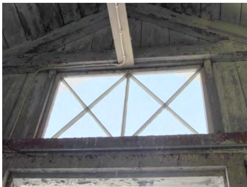
Krysspröjsat fönster på gaveln.
