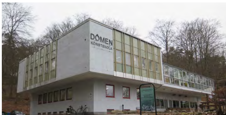
Den södra och den östra fasaden. Här syns den nedre delen med vit spritputsad betong, fönster i rött samt sockel i natursten.
