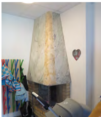
Öppen spis har ersatt en kakelugn i ett av rummen
