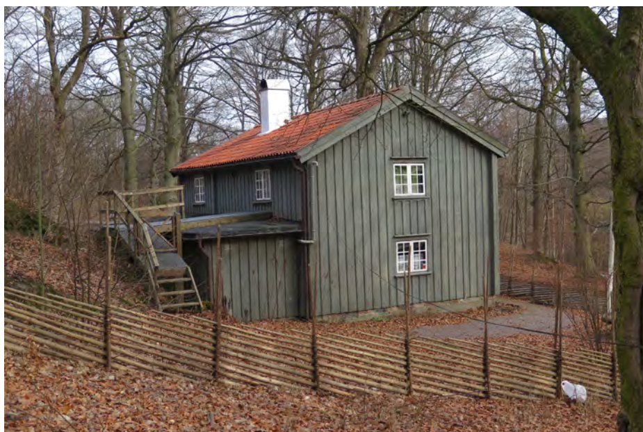
Södra gaveln. Notera utrymningsrampen på baksidans utbyggnas som leder från fönstret på övervåningen
