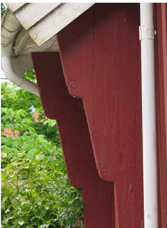
Till vänster en utmejslad detalj i förstukvistens sidor. Nedan ett av fönstren med snedställd panel i luckorna.
