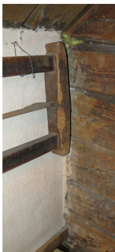
Ytterväggen är reverterad till tak medan gavlarna blottar timret.
