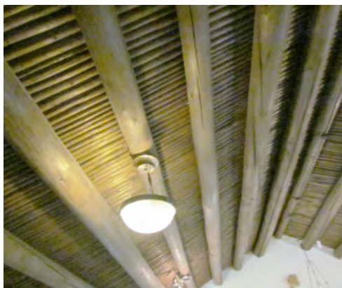
Takåsarna är kraftiga och sitter tätt. Notera också de runda slanorna som vilar på åsarna.
