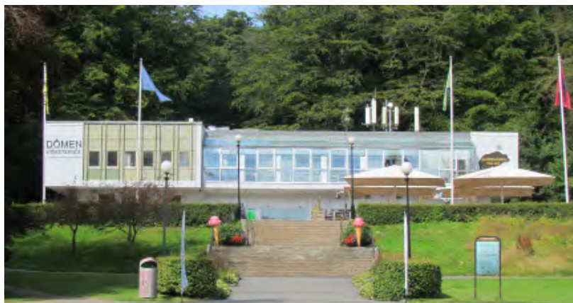
Björngårdsvillans östra fasad som också är entréfasaden. Den vänstra och övre delen av fasaden är något utskjuten och har delvis vitslammat tegel. Notera också den långa inglasade balkongen.
